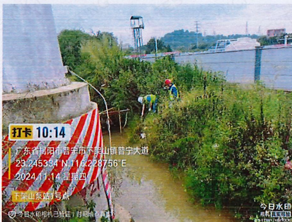
施工 8 标下架山泵站 1 生产废水
