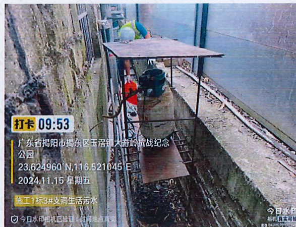
施工 1 标 3#支洞厨房生活污水
