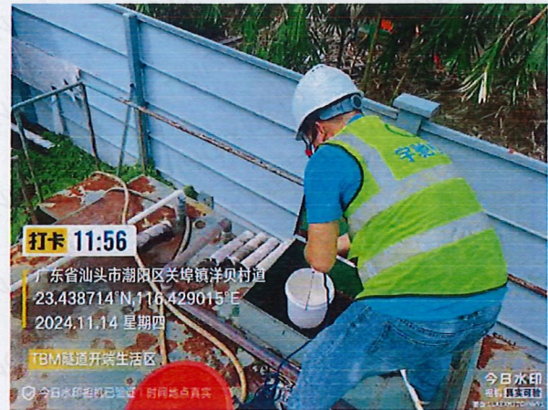
施工 5 标 TBM 隧道开端生活污水
