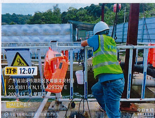
施工 5 标 TBM 隧道开端洞口排水
