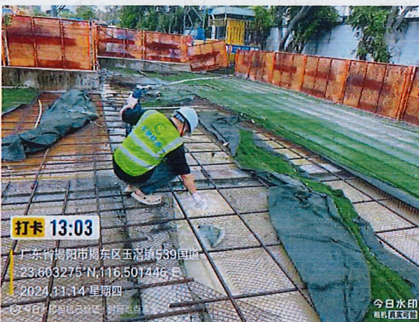
施工 2 标 GX6 生产废水
