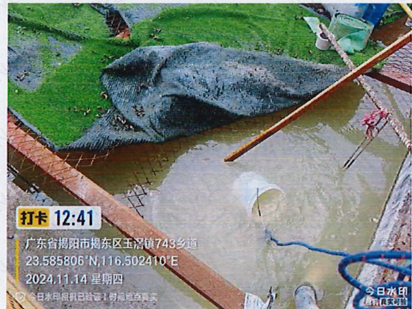
施工 2 标 GX7 生产废水
