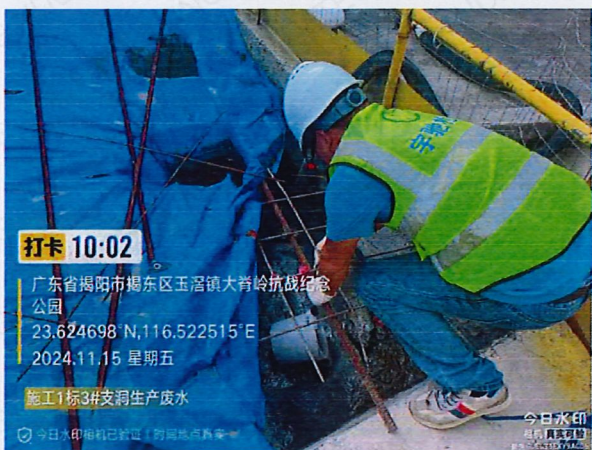
施工 1 标 3#支洞隧道洞口排水
