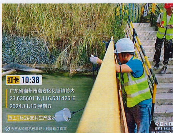
施工 1 标 2#支洞隧道洞口排水
