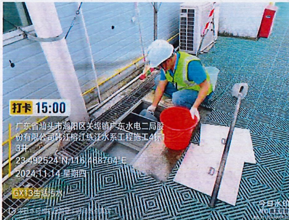
施工 4 标 GX13 厨房生活污水
